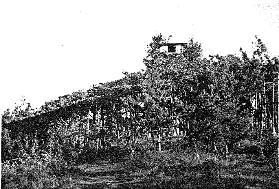
Fig. 2 - Particolare del roccolo con la torre (Foto G. Boano).
